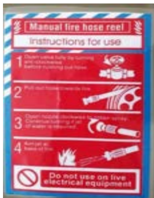
Peralatan Pencegahan Kebakaran
